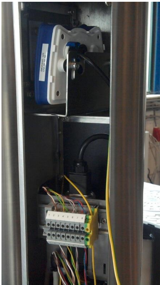
Figuur 42 Inbouwdoos achter de klemmenstrook
