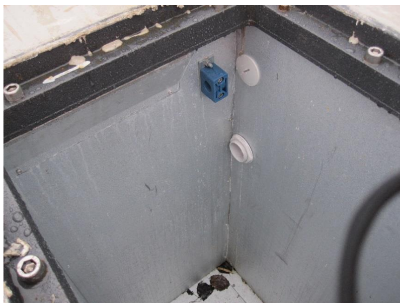
Figuur 57 De binnenkant van de fundatie
