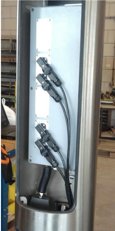
Figuur 35 Binnenkast in de slave zuil met data verbindingen
