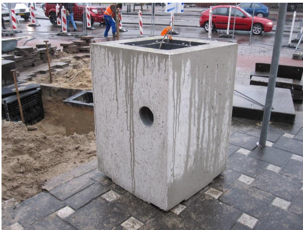
Figuur 58 De buitenkant van de fundatie
