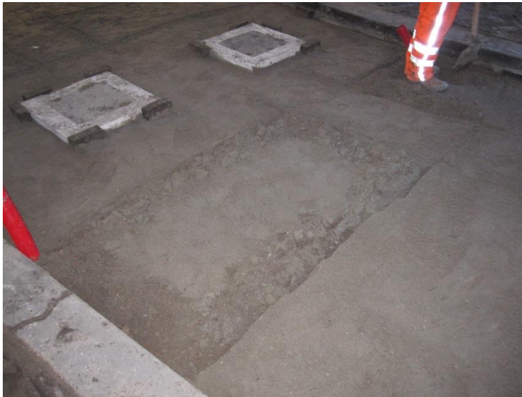
Figuur 14 Het maken van een lus onder klinkers
