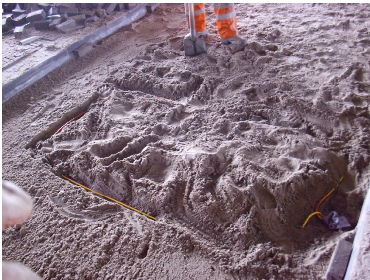
Figuur 15 Luskabel wordt in de grond gelegd
