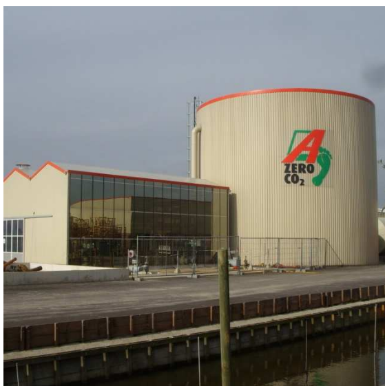
Figuur A1 2 Geothermie Pijnacker-Noord waarbij tuinder Ammerlaan via een warmtenet aan andere tuinders, utiliteitsgebouwen en 470 appartementen warmte levert (10TJ/j)
