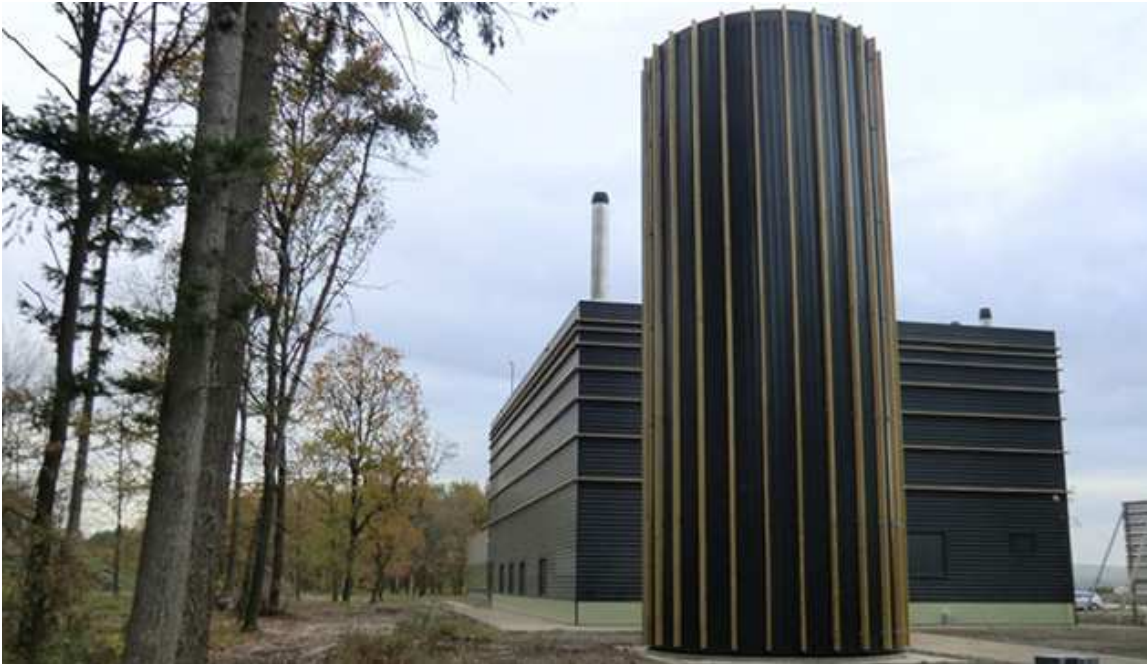
Hernieuwbare warmtevoorziening van een wijk. Warmtebuffer op de voorgrond
