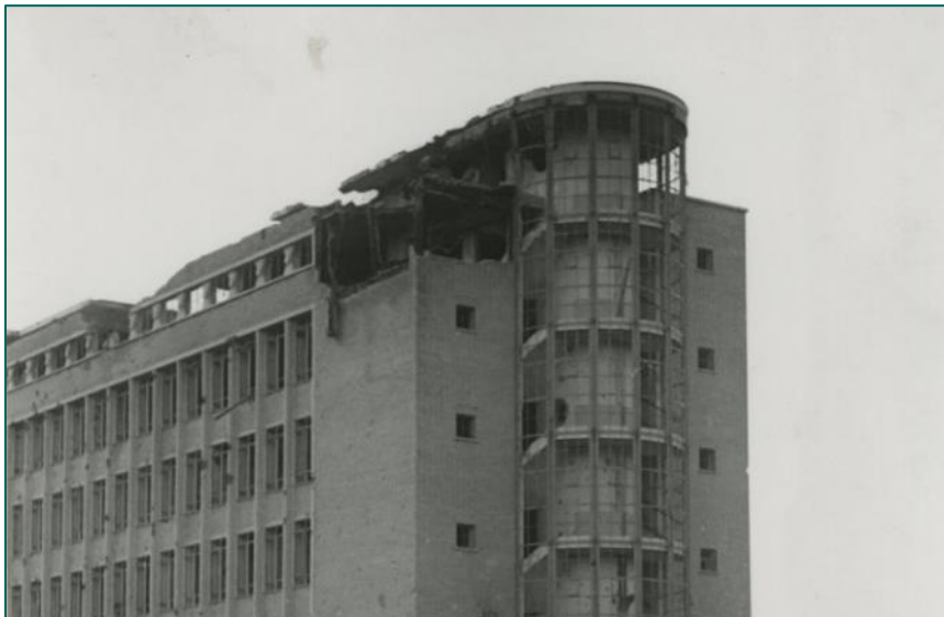
Figuur 265: Bomschade gebouw B.I.M., september 1945. (Bron: Haagse Beeldbank)
