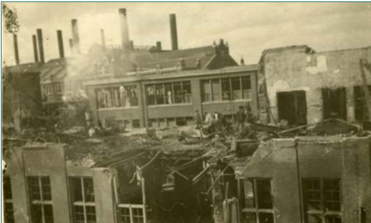
Figuur 157: Foto d.d. 4 mei 1943. Schade aan het Telefoongebouw. (Bron: Haagse Beeldbank).
