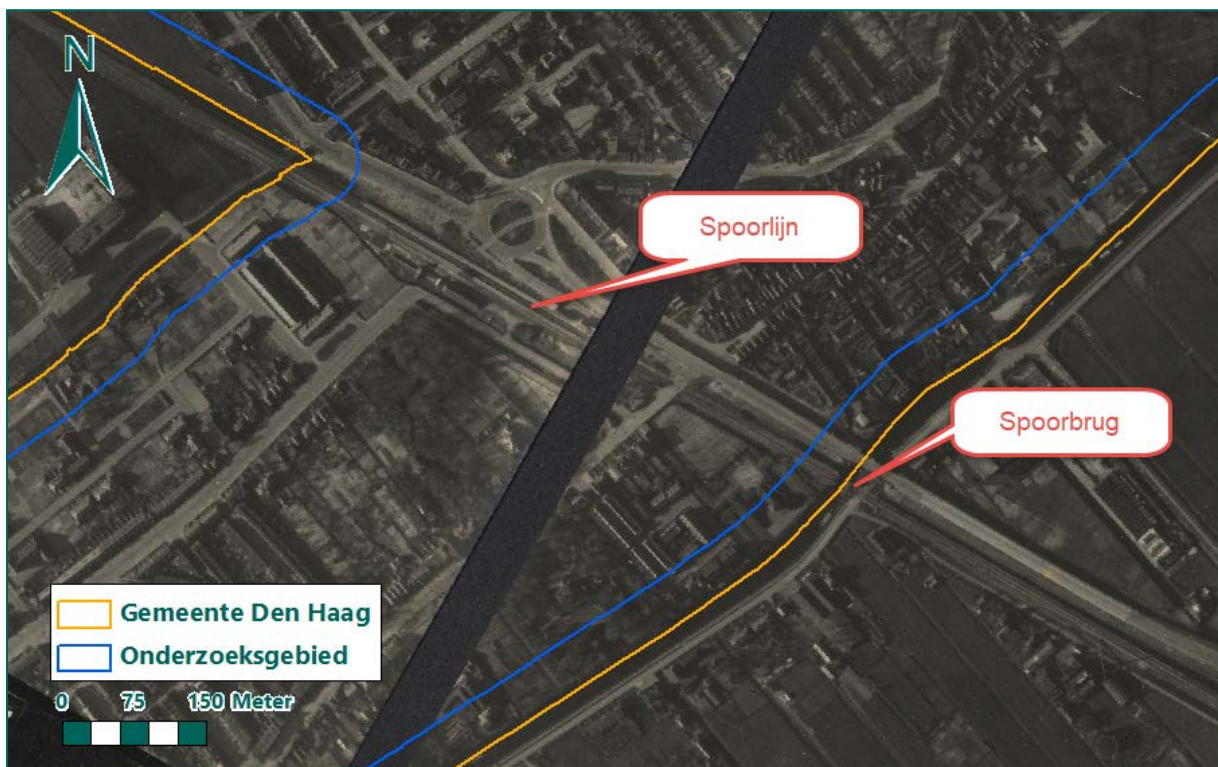
Figuur 222: Luchtfoto's d.d. 7 april 1945 van de spoorlijn en spoorbrug bij Voorburg. (bron: Wageningen UR).
