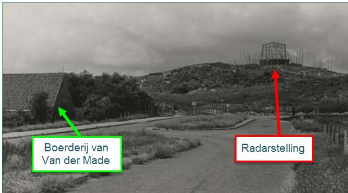
Figuur 126: Boerderij van der Made en een in aanbouw zijnde radarstelling (Duits terrein) op een foto uit 1941. (bron: Haagse Beeldbank).
