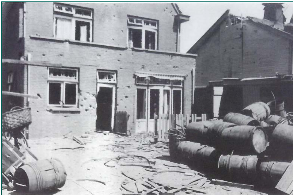
Figuur 74: Schade aan de woning van de familie Jol, Treilerweg 51. (bron: bijlage 3, BAL, pag. 139).
