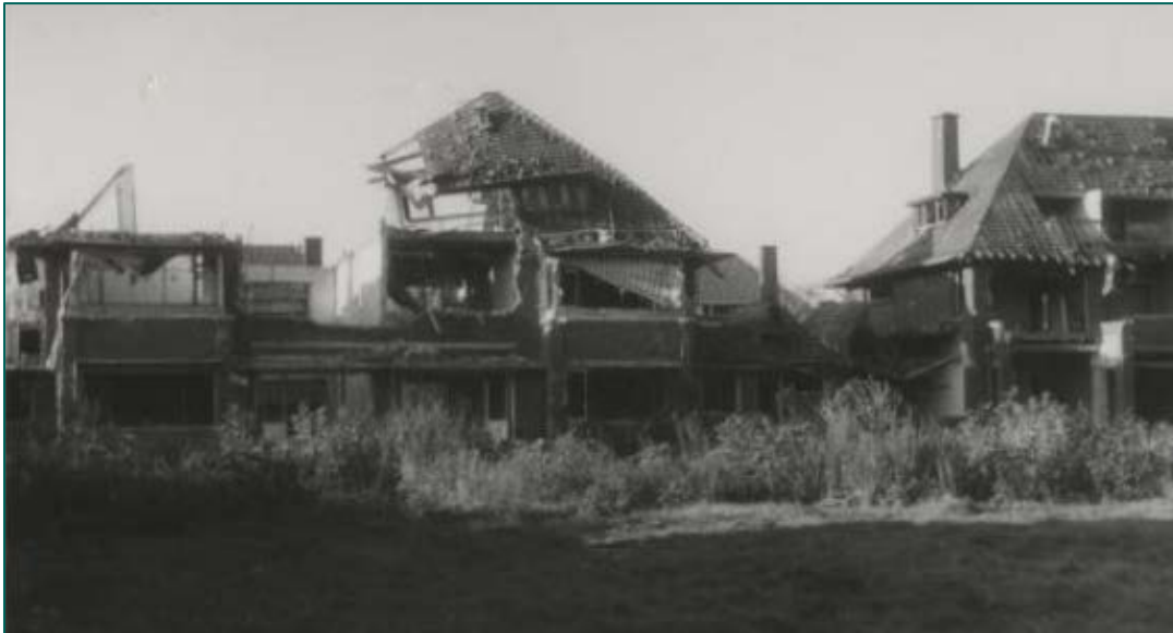
Figuur 178: Offenberglaan 1, parkflat 'Marlot', oorlogsschade, oktober 1945. (bron: Haagse Beeldbank).
