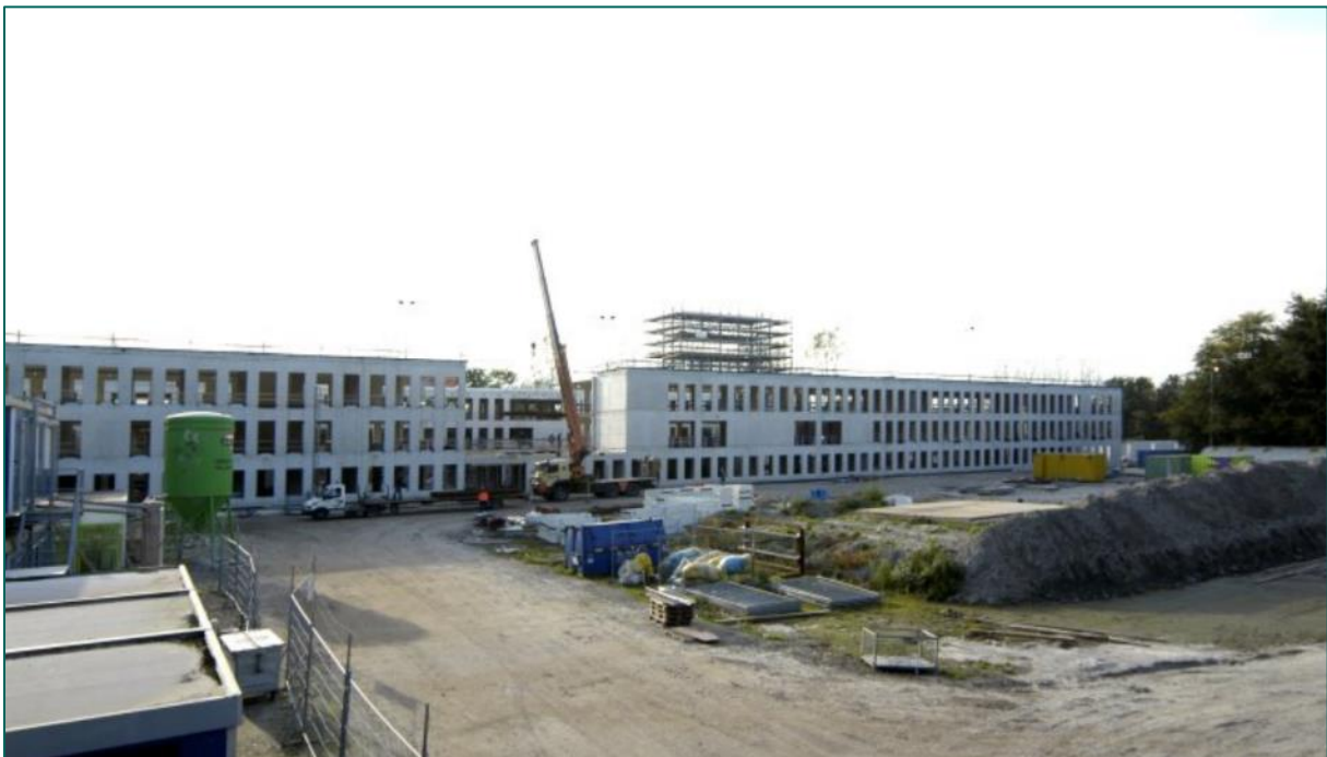
Figuur 315: Wijndaelerlaan. Bouwplaats Internationale school, 17 oktober 2005. (bron: Haagse Beeldbank).
