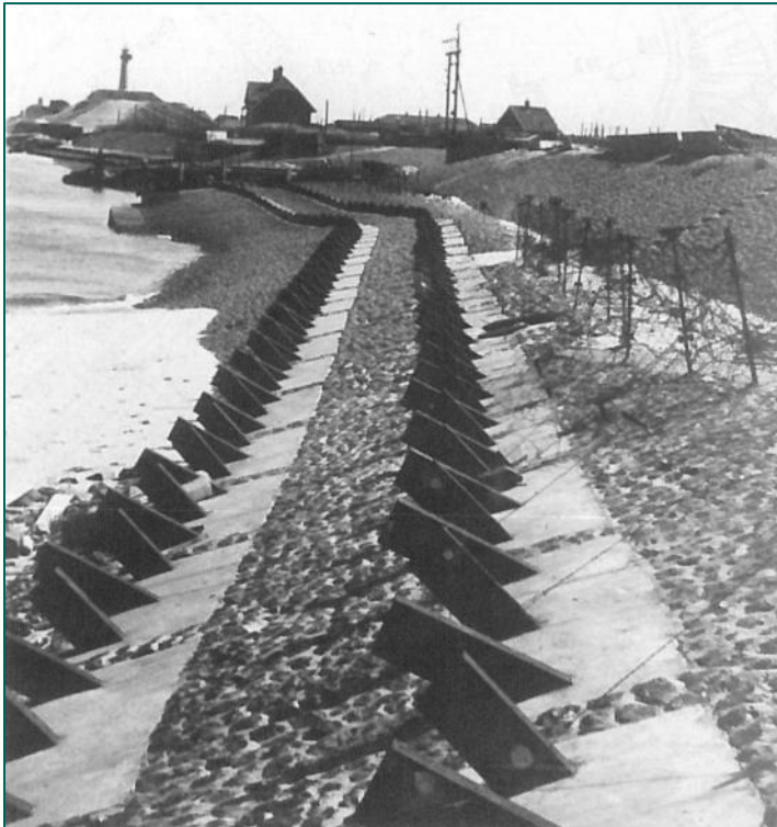
Figuur 349: Voorbeeld van uitstekende ijzeren balken in Scheveningen. (Bron: BAL, pag. 10).
