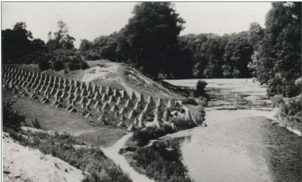
Figuur 341: Voorbeeld van drakentanden (tankversperringen) bij de Scheveningse Bosjes).
