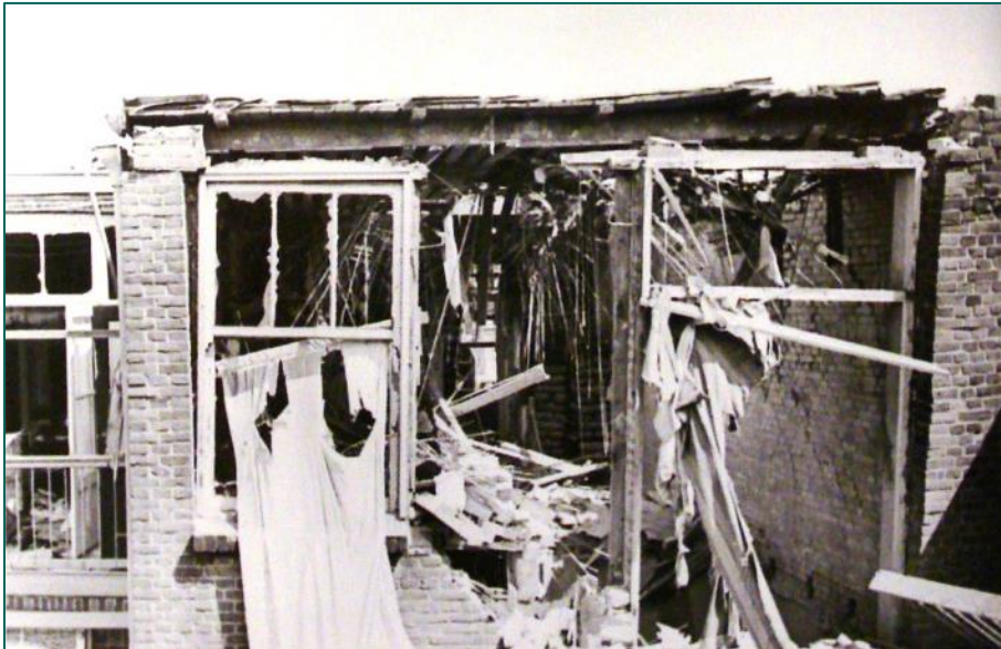
Figuur 78: Schade Valkenboschkade 166. (bron: bijlage 4, archief Gemeentelijke Luchtbeschermingsdienst Den Haag, inv. 101).
